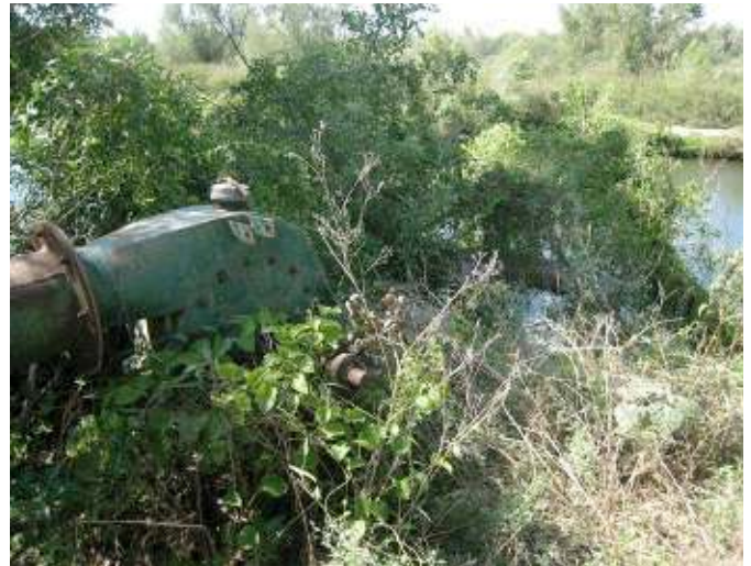
Una bomba utilizada para extraer el agua del Río Fuerte hacia los canales de riego
